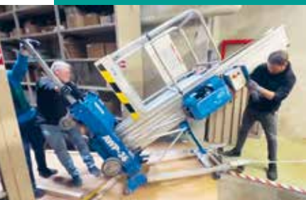
Installation de la nacelle de dépannage
